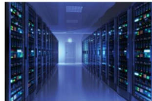
中航油数字化油库控制系统防雷工程
